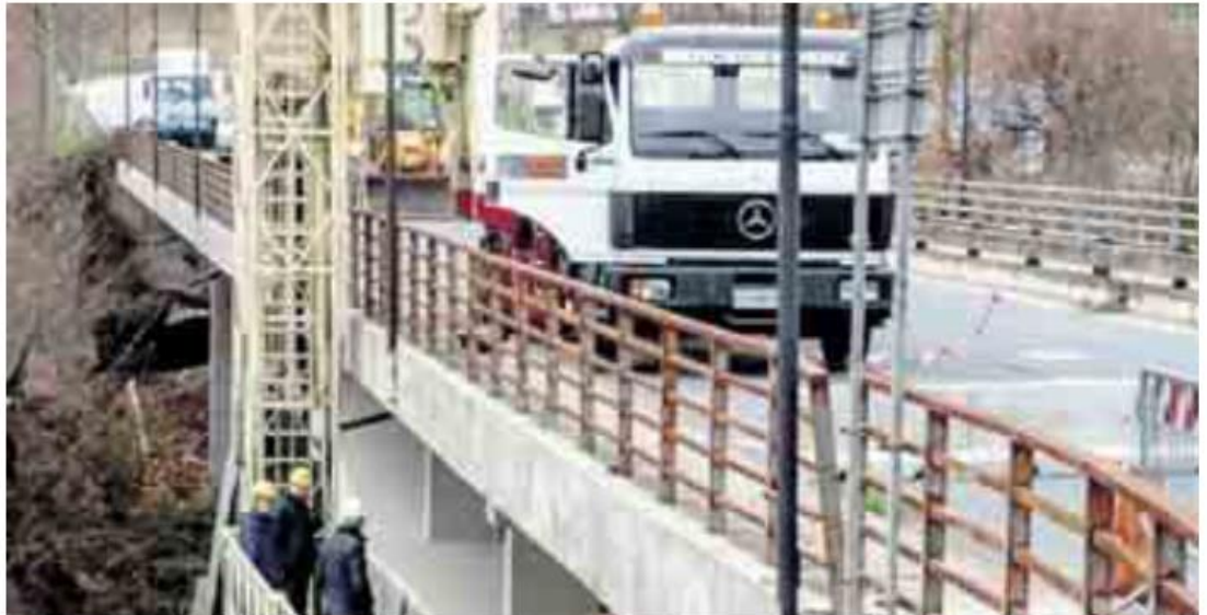
I lavori attualmente in corso al ponte dei Conciatori
