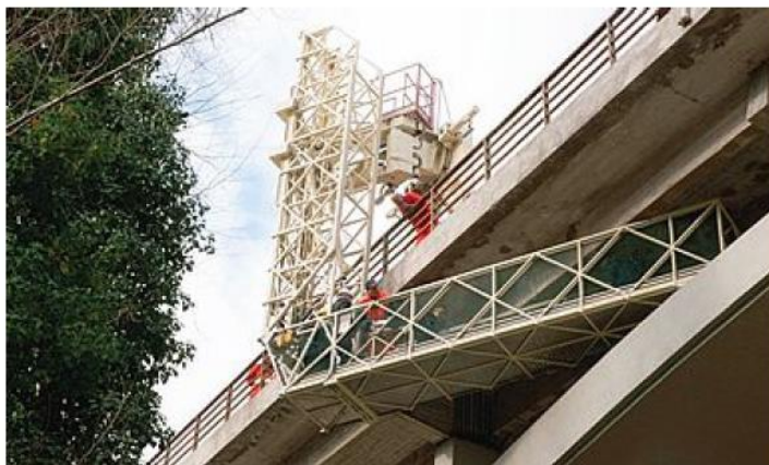
L'ACCERTAMENTO Continuano ispezioni e verifiche per capire se il ponte dei Conciatori possa essere riaperto con la stessa soletta
