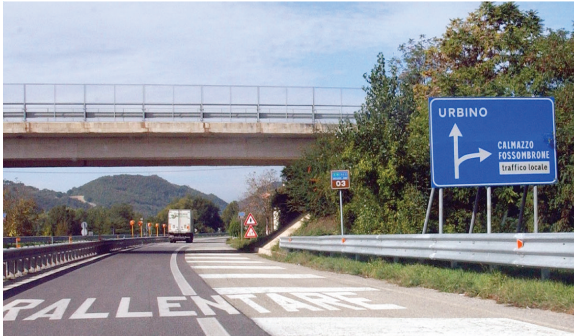
LA RIPARTENZA Ecco il punto dove finisce attualmente la Fano-Grosseto, all'altezza di Canavaccio di Urbino. E' da lì che mancano 34 chilometri per collegarsi alla galleria della Guinza, ultimata nel 2004
