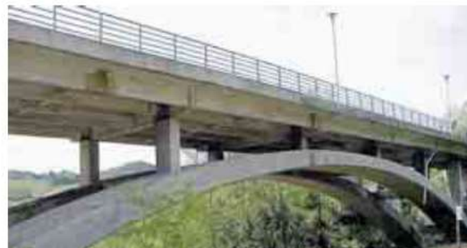
Il ponte dei Conciatori
