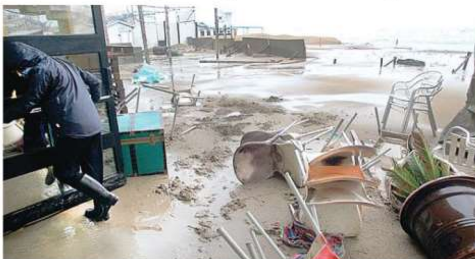
SULLA COSTA E NELL'ENTROTERRA I danni del maltempo del marzo scorso: a sinistra un bagno lungo la costa pesarese, a destra frane a Sassocorvaro
