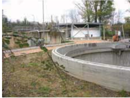
Nuovo depuratore in fase di realizzazione
