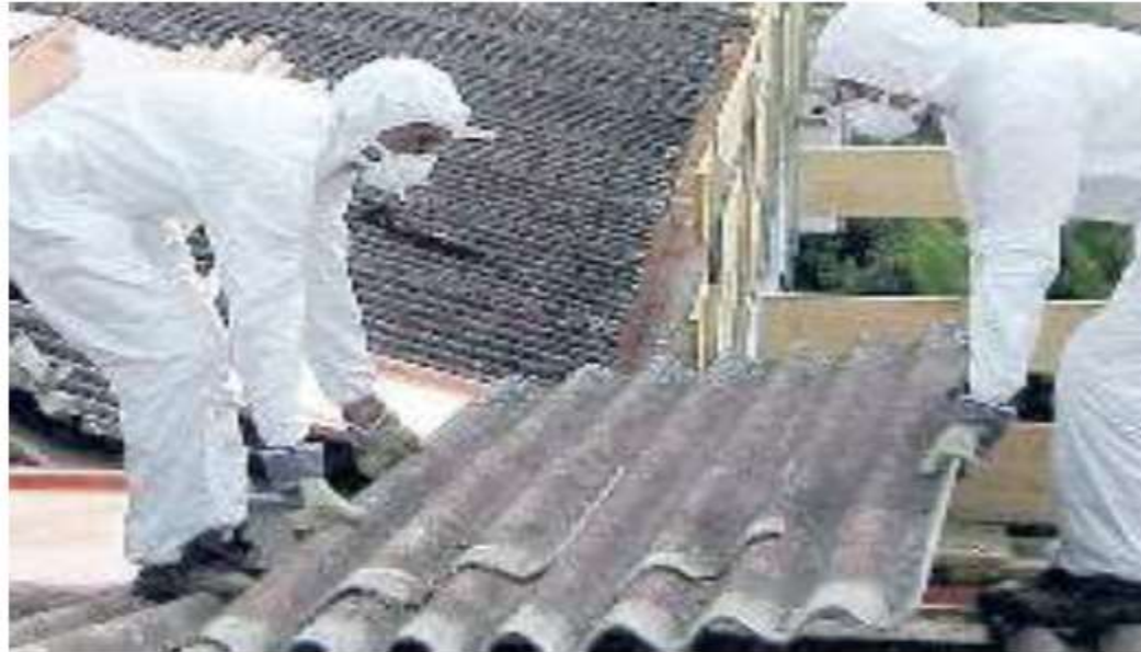
Operai al lavoro per rimuovere un tetto in Eternit
